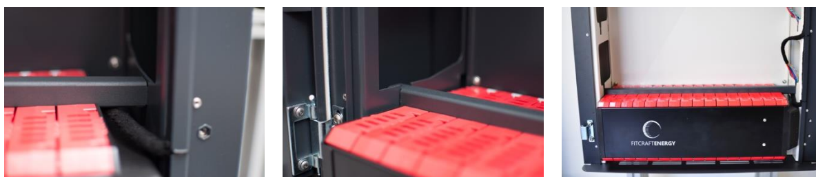
Obrázek 23 - nasazení upevňovací tyče pro upevnění baterií
