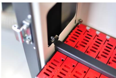
Obrázek 24 – šroub pro zajištění upevňovací tyče pro upevnění baterií
