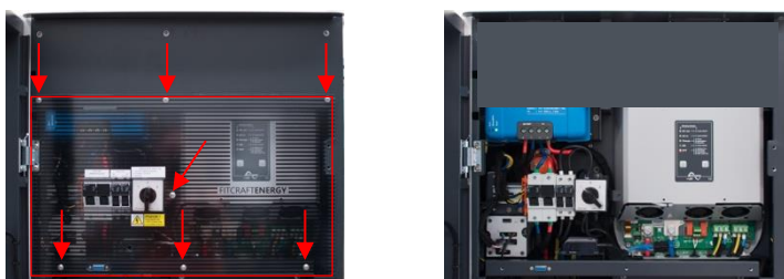
Obrázek 14 - demontáž plexy krytu hlavních zařízení
